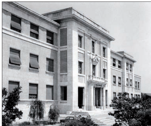
Facoltà di Ingegneria - Ingresso da Via Diotisalvi - anni '60
